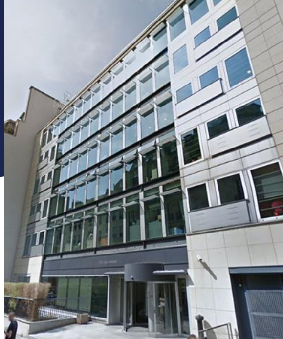
43 rue Vineuse, Paris 16 (immeuble de bureaux)
