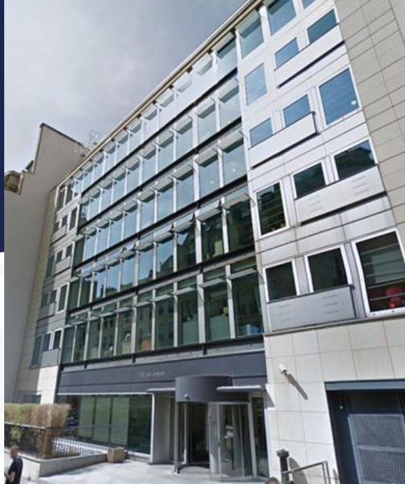
43 rue Vineuse, Paris 16 (immeuble de bureaux)
